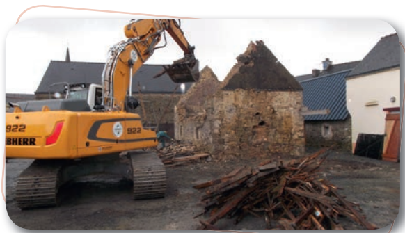
Démolition des ruines pour le parking de la Fontaine.
